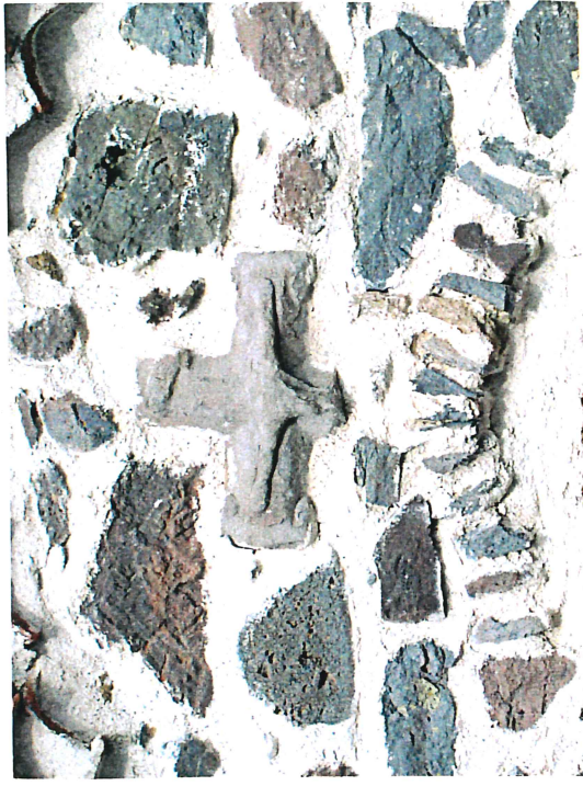
Mur : pierres de la carrière à olivines
